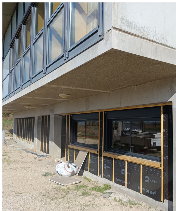
Locaux en travaux, réception fin d'année
